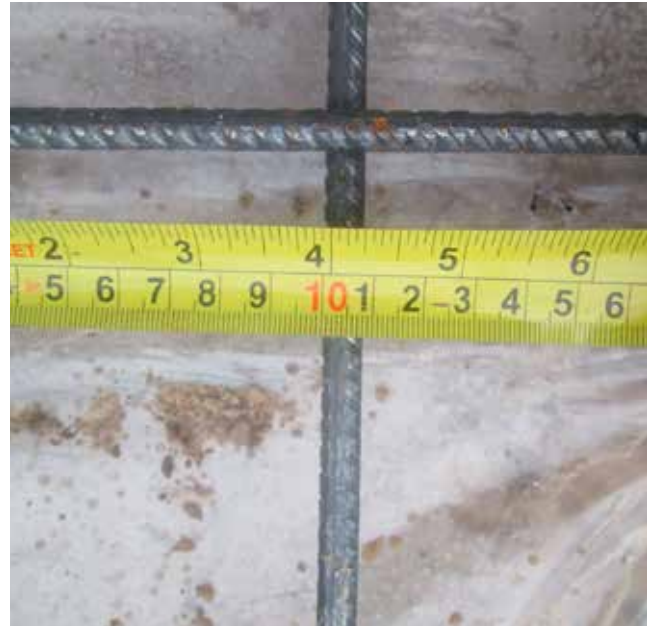
Controle van de wapening
