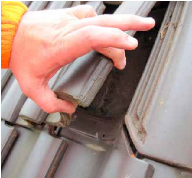
Dakinspectie keramische pannen
