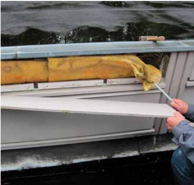
Inspectie van toegepaste isolatie gevel en dak
