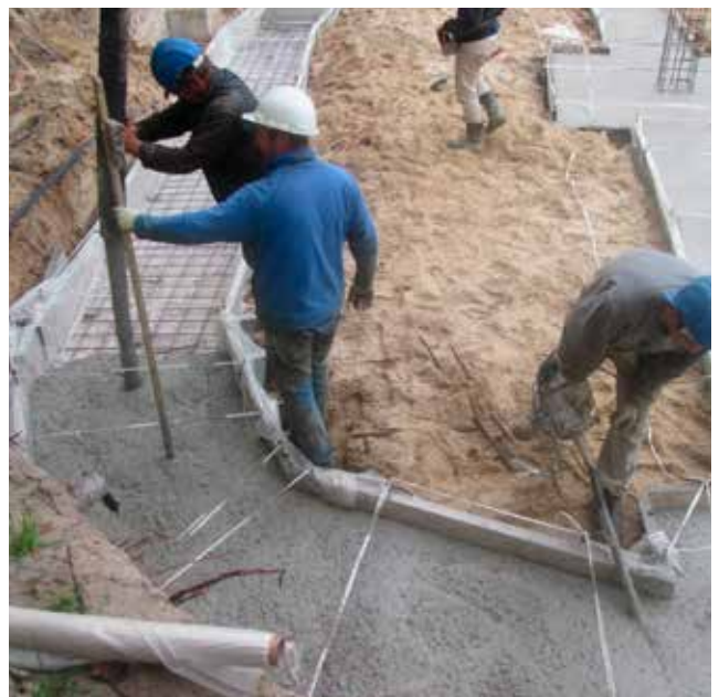
Storten van funderingssloof Multifunctioneel Zalencentrum De Kiekmure te Harderwijk
