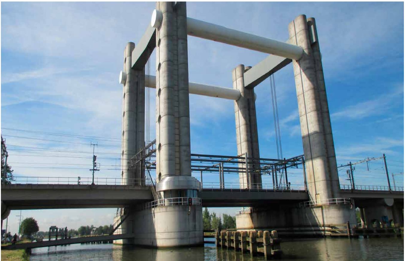
Hefbrug over de Gouwe te Gouda
