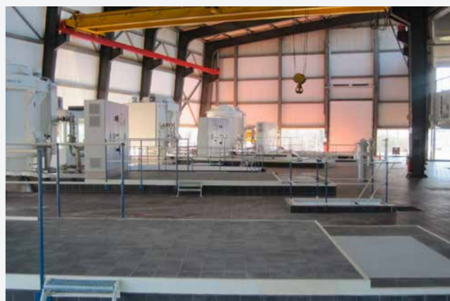
Hal elektromotoren poldergemaal
