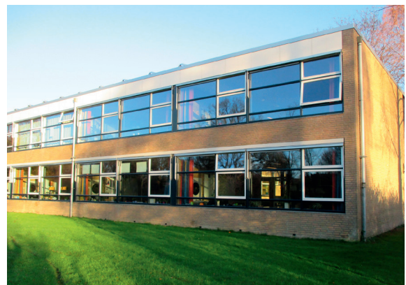
Schoolgebouw te Ommen
