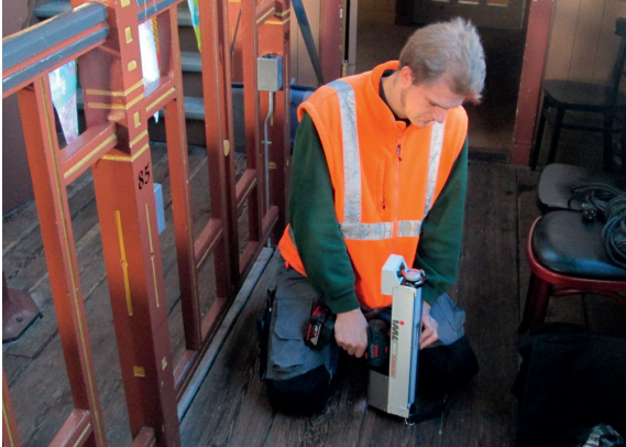
Resistograafmeting van houten vloer
