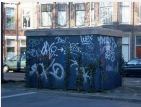
Transformatorhuisje in Den Haag
